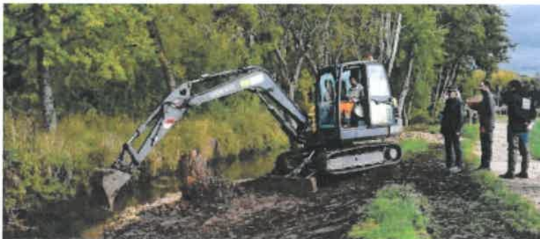
Des travaux importants ont été effectués pour le cours d'eau.
